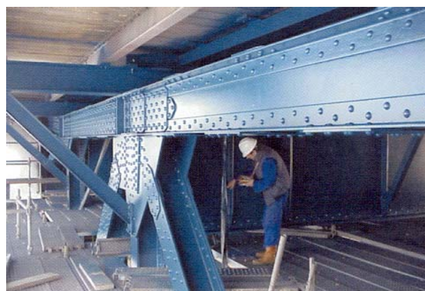
Окончательная приемка покрытия
