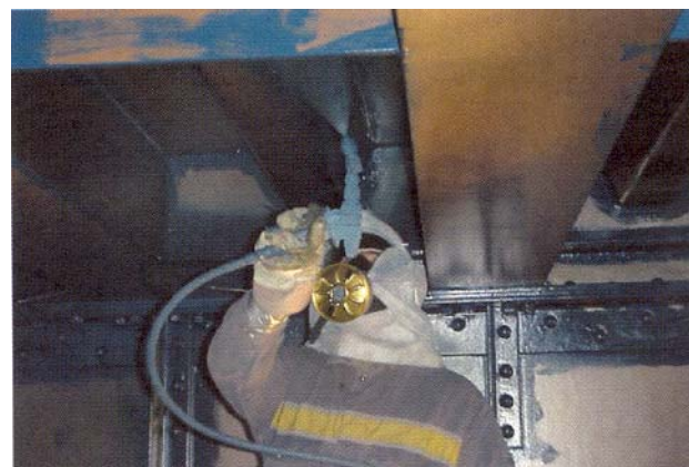
Нанесение ЛКМ методом безвоздушного распыления
