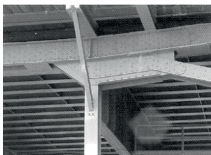
Профессионально выполненные работы - отличное состояние мостовых конструкций.
