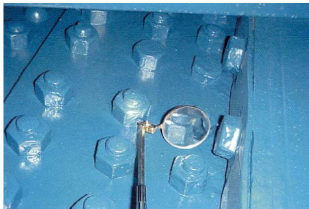
Инспекторский контроль окраски труднодоступных мест
