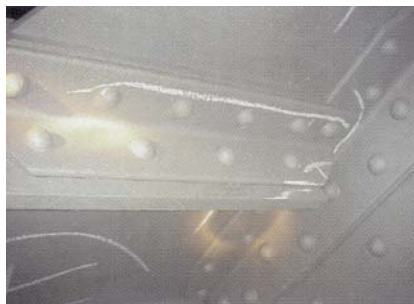
Инспекция после пескоструйной очистки до стандарта SA2 1/2 .
