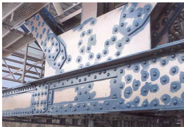
Конструкция после полосовой окраски
